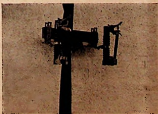
De smeltdraadhouder tilt men uit de contacthouder door met de stok in de naar buiten gekomen ring te grijpen
